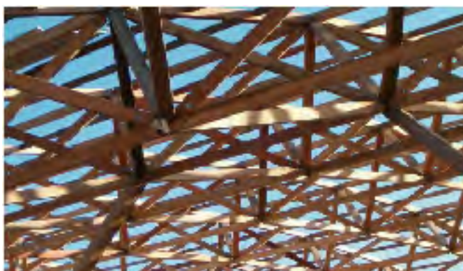
Vue de la structure tridimensionnelle courbe en bois
