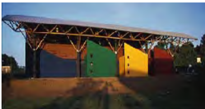
La façade ouest et les trois locaux techniques et de rangement
