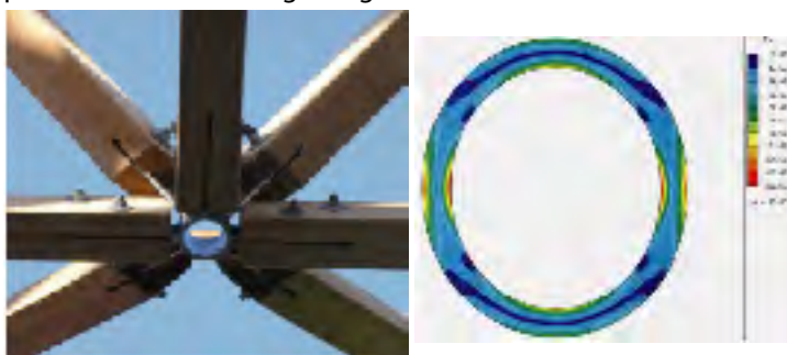
Détail de l'assemblage et modélisation des déformations.
