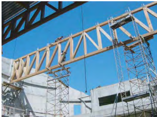
La poutre principale de l'auditorium, en cours de montage
