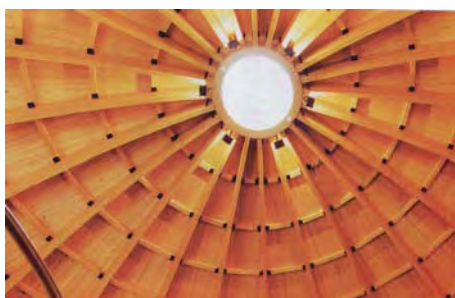
le collage du lamellé collé pour charpente doit être particulièrement soigné car la stabilité de l'ouvrage en dépend
