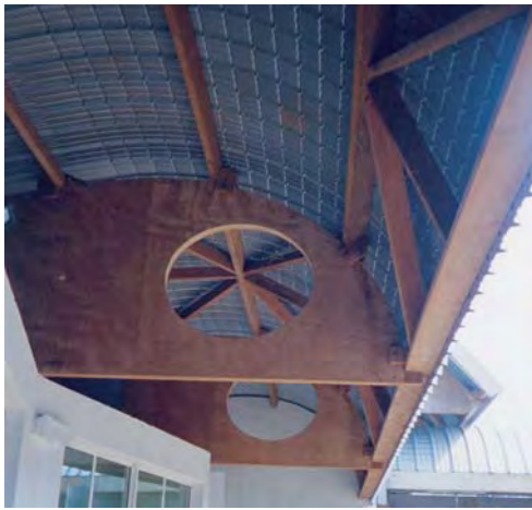
Détail des cercles réalisés dans du contreplaqué
