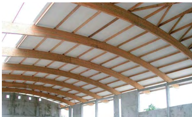
La charpente du Gymnase, en lamellé collé de Douglas.
