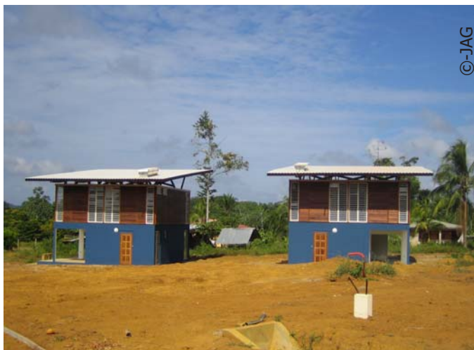
Les logements de fonction sont équipés de chauffe-eau solaires
