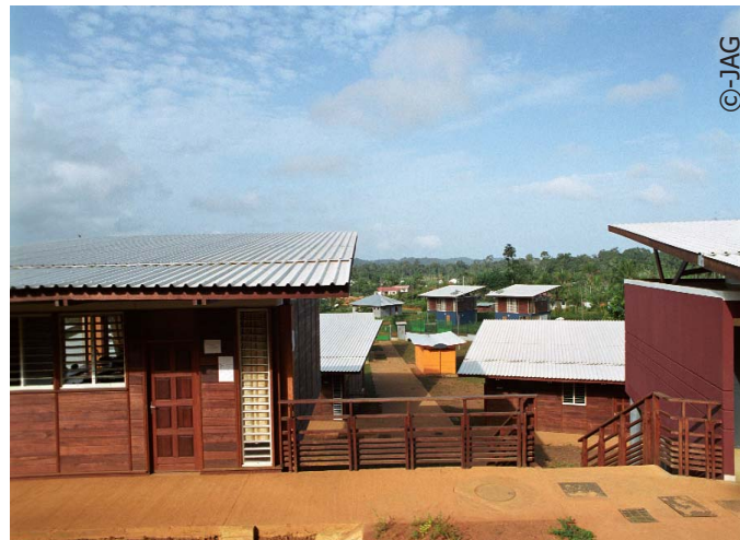
Vue générale du collège.
