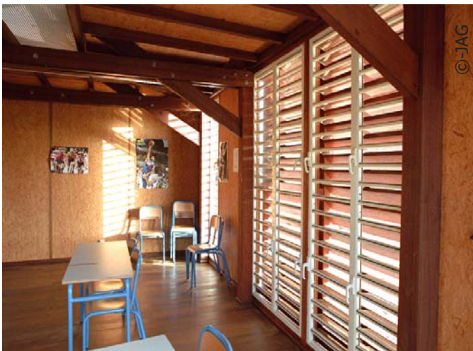
L'intérieur des classes est protégé de la chaleur par les pare-soleil disposés sur les ventelles côté ouest.
