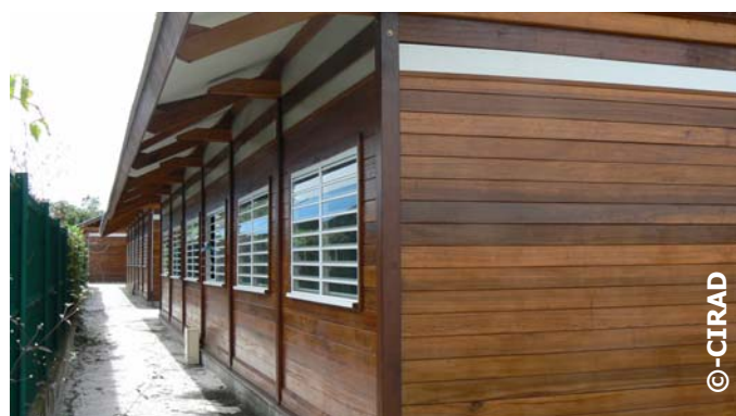
Les lisses basses en bois reposent sur une dalle béton au sol.
