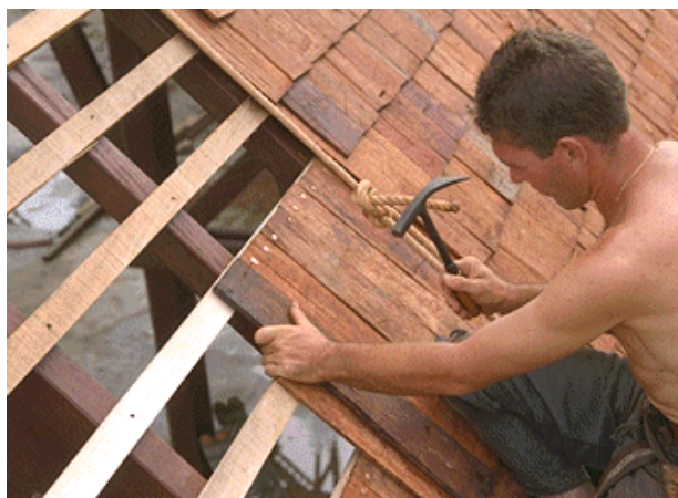
Clouage dans la partie supérieure
