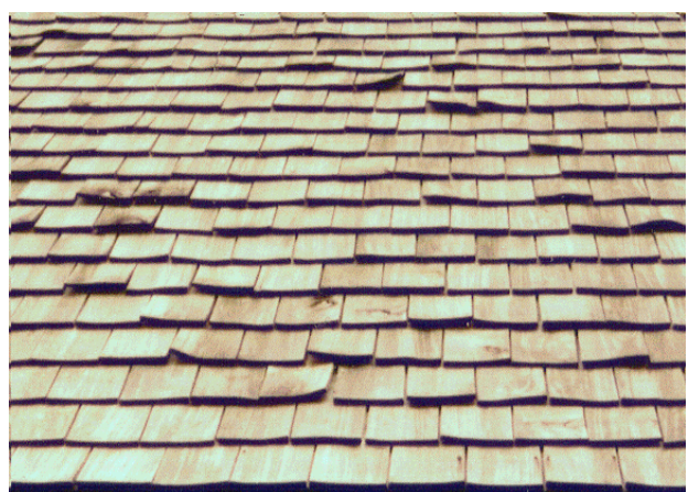
Couverture en bardeaux sciés.
