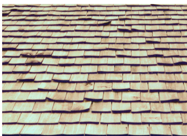
Couverture en bardeaux sciés.
